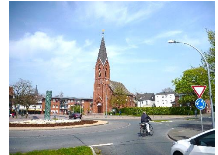
2016: Christuskirche, BJ 1900, isoliert im Zentrum
