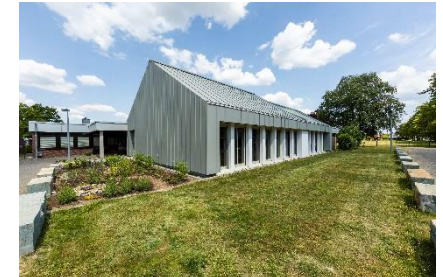
2020 modernisiert (auch energ.): heute Emmaus-
